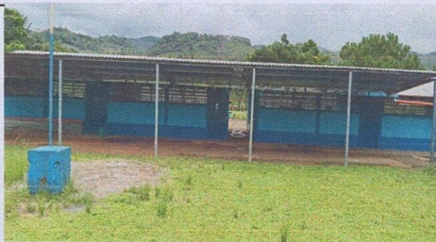
Foto 3: Imagen donde se ve el corredor con el nuevo entechado.
