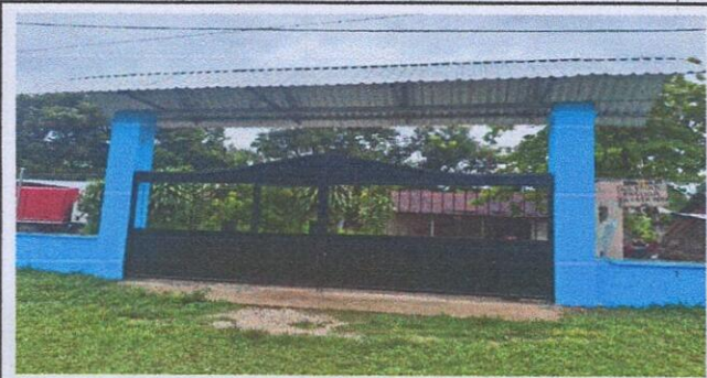
Foto 5: Imagen en donde se muestra la pintada de porton principal.
