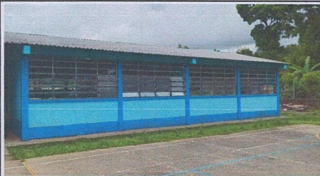
Foto 1: Imagen donde muestra la nueva pintura que se aplicó.
