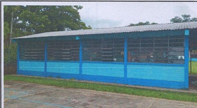
Foto 2: Imagen donde se ve el otro modulo pintada.
