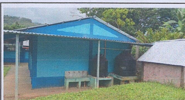
Foto 4: Imagen donde se ve el nuevo techo de las lavamanos.
